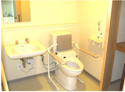
《トイレ（手すり付き）》
